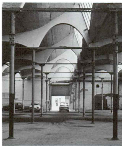
La volta de maó de pla va ser emprada en innumerables edificis, de vegades amb gran expressivitat. Interior de la fàbrica Aymerich Amat i Jover de Terrassa construïda l'any 1909.
